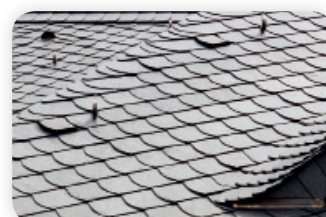
Flächenlüfter in Form der Eindeckung - optisch äußerst ansprechend.
