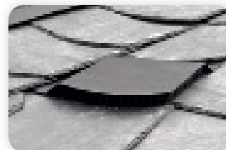
Flächenlüfter in Form der Eindeckung - optisch äußerst ansprechend.
